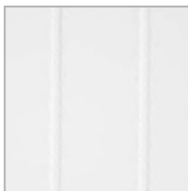
frézování na povrchu křídla
