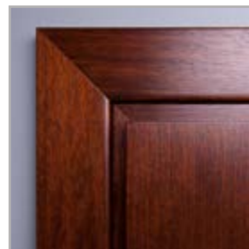
spojování lišt pod úhlem 45°
