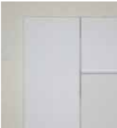
VOĹITELNÉ SPOJENÍ OBLOŽEK POD ÚHLEM 90°
