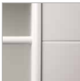
pohled na frézování
